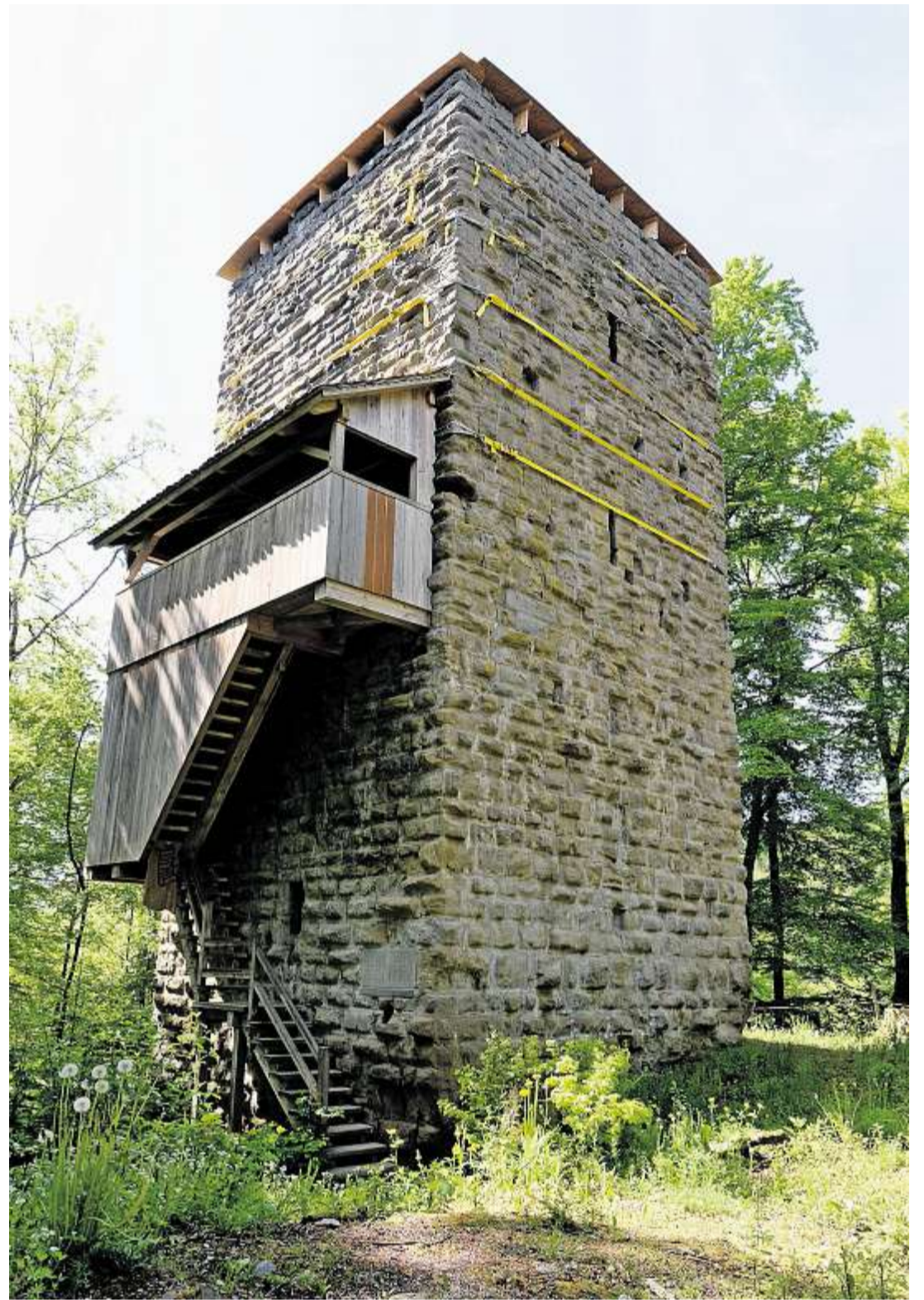
Heute wird die Burgruine provisorisch mit Spannssets gesichert. Die Sanierung wird teurer als erwartet. Heinz Diener
