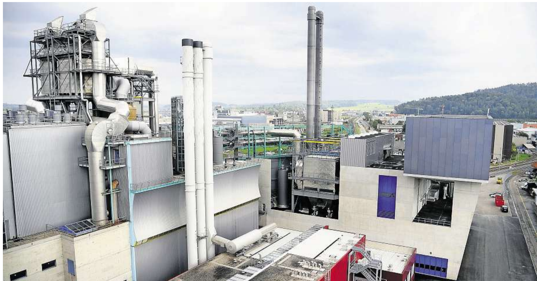
Das teuerste Gebäude der Stadt: Der Umbau der KVA in der Grüze kostete einen dreistelligen Millionenbetrag. Unter anderem wurden ein Ofen ersetzt und das Abfalllager vergrössert. Marc Dahinden
